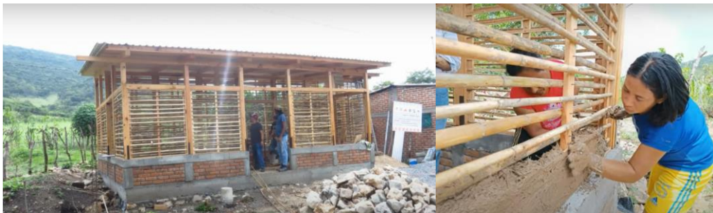
Imagen 3.35. Elaboración, montaje del panel entre polines y colocación de bambú
